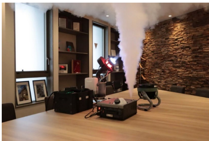
【現本社ビル会議室への「ナノメタックスコーティング」施工の様子】
